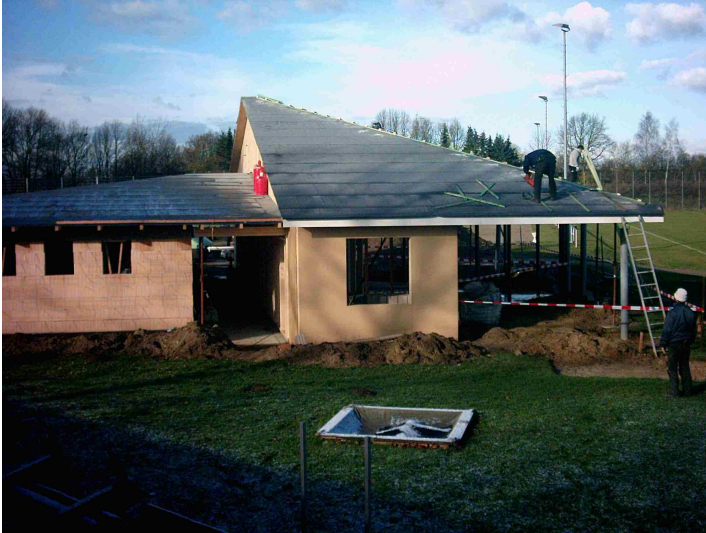
Dachstuhl drauf Am Tag des Richtfestes (19.11.04)
