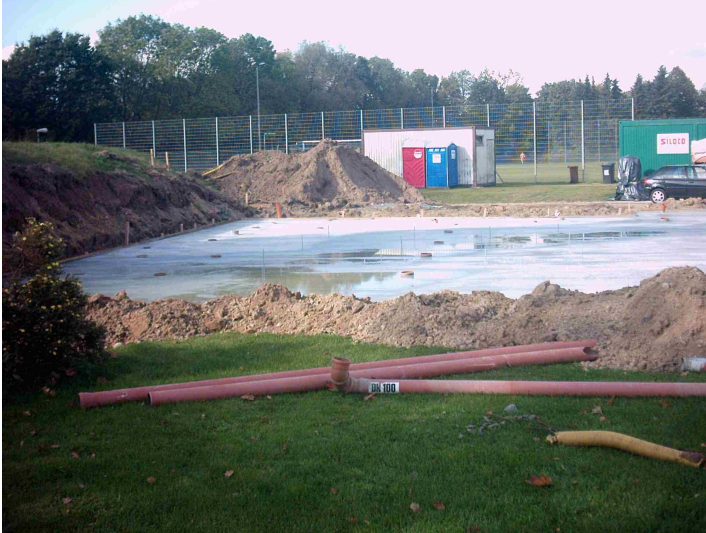
Der Architekt beim Einmessen Das Fundament ist fertig
